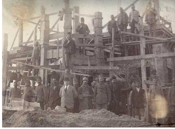
Resim 3.2.2.14: Tapu Kadastro Binasının inşaat yapılırken görüntüsü ( https://www.tkgm.gov.tr/tr/icerik/tarihce-1 , erişim tarihi 21.12.2020.).
