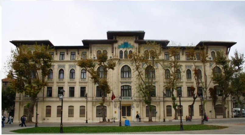
Resim 3.2.2.16: Deftter-i Hakani günümüzdeki durumu ( https://www.kalinti-istanbul.com/item/deftter-i-hakani-binasi , erişim tarihi 19.11.2020).
