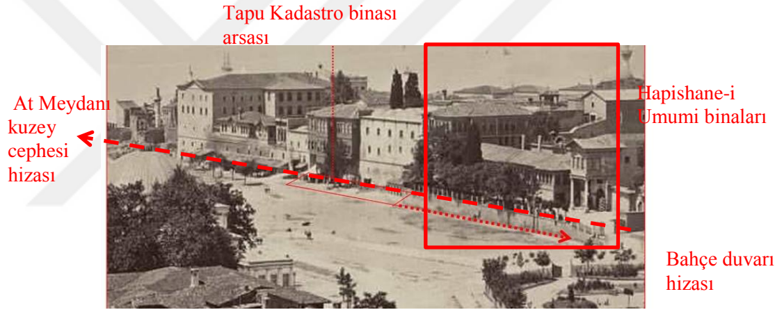
Resim 3.2.2.13: Tapu Kadastro binasının arsasının At Meydanındaki konumu
