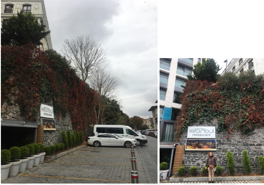
Resim 3.1.4: Ümraniye Öktem caddesi ve Işık sokağı arasındaki istinat duvarı .
