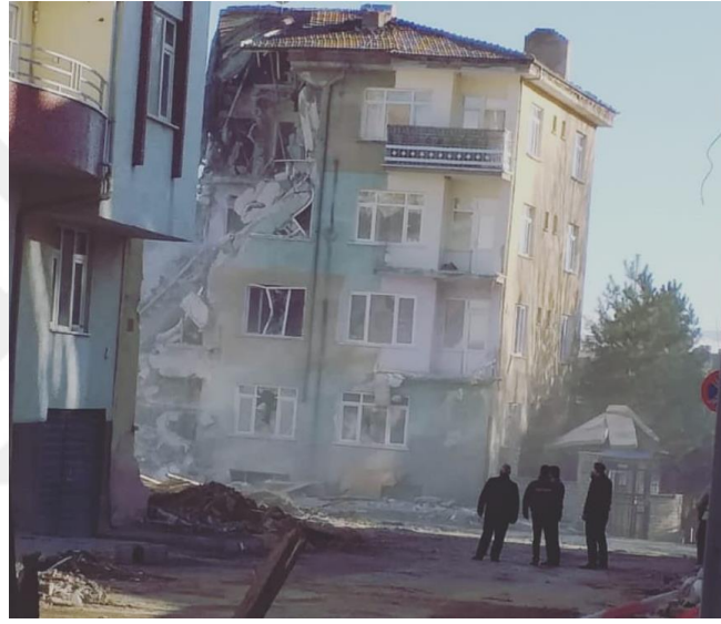
Şekil 3-9: Binanın Yıkım Aşaması
