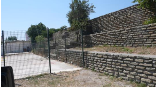
Fotoğraf 1.17. ve 1.18. Hamzakoy – Feneraltı mevkiinde kaba yonu taş duvar örgü sistemindeki kumtaşlarının dizilimi
