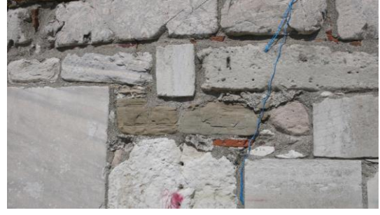
Fotoğraf 1.9. ve 1.10. Gelibolu Kalesi'nde kullanılan farklı kayaçlar ve bozulmalar
