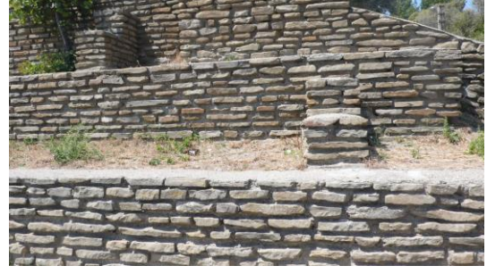
Fotoğraf 1.17. ve 1.18. Hamzakoy – Feneraltı mevkiinde kaba yonu taş duvar örgü sistemindeki kumtaşlarının dizilimi
