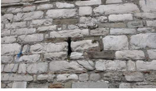
Fotoğraf 1.9. ve 1.10. Gelibolu Kalesi'nde kullanılan farklı kayaçlar ve bozulmalar
