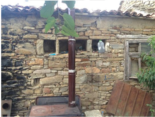
Fotoğraf 1.60. ve 1.61. Basınca ve çekmeye birlikte çalışan kumtaşlarının dizilimi
