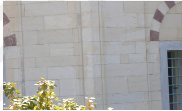
Fotoğraf 1.19. ve 1.20. Kaptan-ı Derya Rumeli Beylerbeyi Sinan Paşa Türbesi beden duvarlarında küfeki taşlarda yapılan plastik onarımlar
