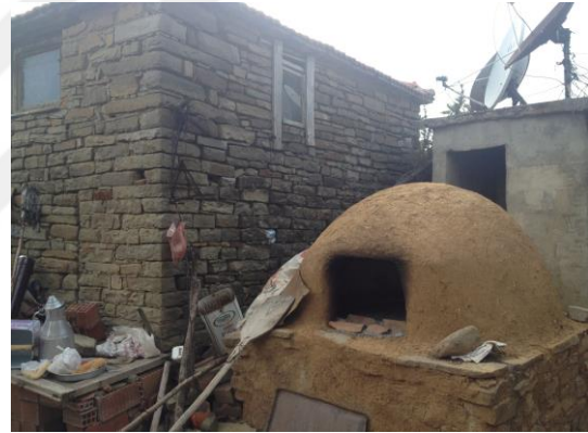
Fotoğraf 1.60. ve 1.61. Basınca ve çekmeye birlikte çalışan kumtaşlarının dizilimi
