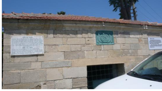
Fotoğraf 1.23. Emir Ali Paşa Türbesi'nin beden duvarlarındaki kesme taş örgü sisteminde volkanik kayaların kullanımı
