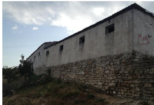
Fotoğraf 1.30. ve 1.31. Kumtaşlarından örülü duvarların temel olarak kullanımı
