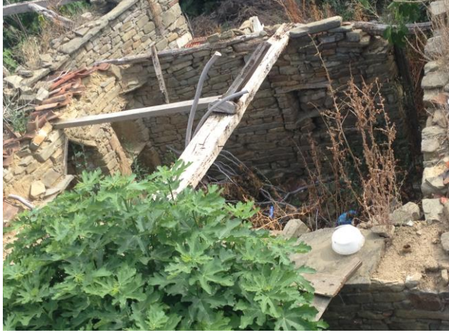
Foto. 1.62.-1.63. Çatısı çökmüş durumdaki yapının üstten görünüşü ile duvar kesiti
