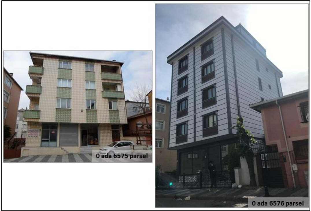
Şekil 4-29: 2 nolu örnek riskli yapı yıkım öncesi-inşa sonrası (Sol, ÇŞB-Kentsel Dönüşüm Bilgi Sistemi, Sağ Kişisel Arşiv, 2019)
