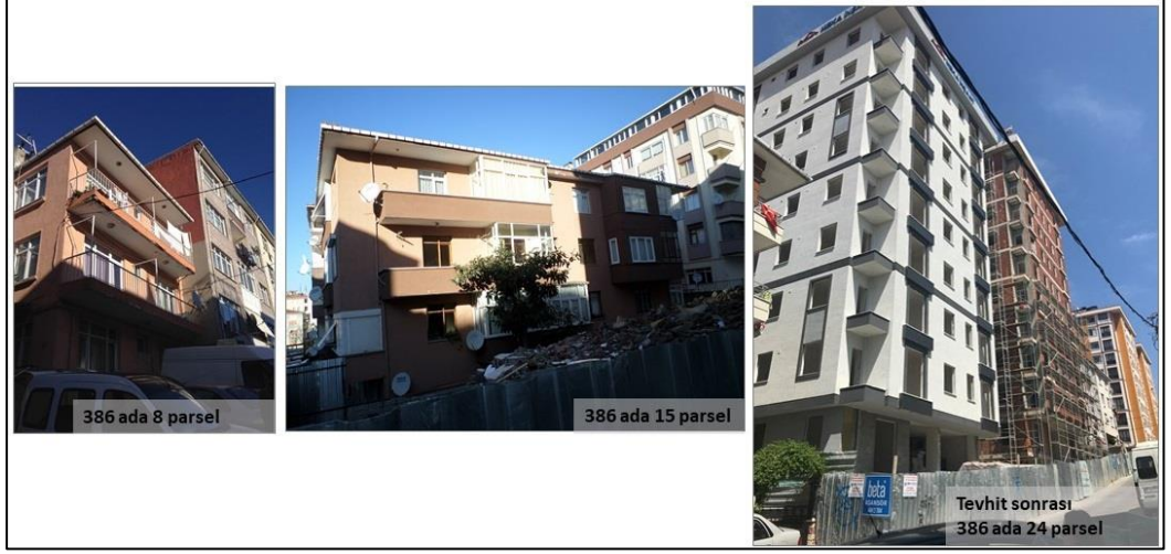
Şekil 4-16: 3 nolu örnek riskli yapı yıkım öncesi-inşa sonrası (Sol, ÇŞB-Kentsel Dönüşüm Bilgi Sistemi, Sağ Kişisel Arşiv, 2019)
