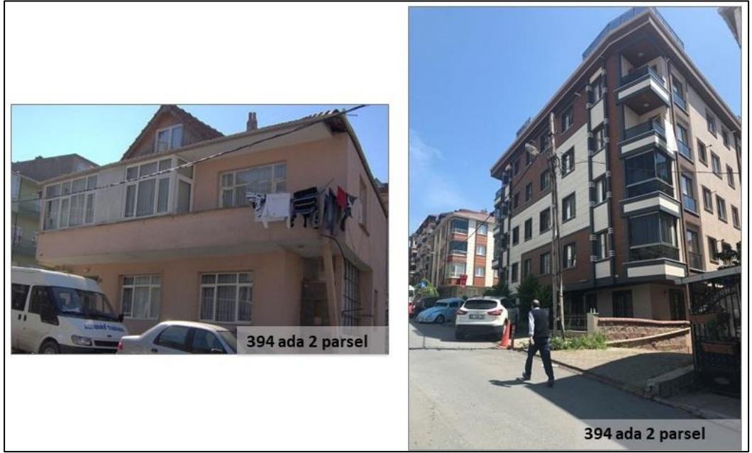
Şekil 4-17: 4 nolu örnek riskli yapı yıkım öncesi-inşa sonrası (Sol, ÇŞB-Kentsel Dönüşüm Bilgi Sistemi, Sağ Kişisel Arşiv, 2019)
