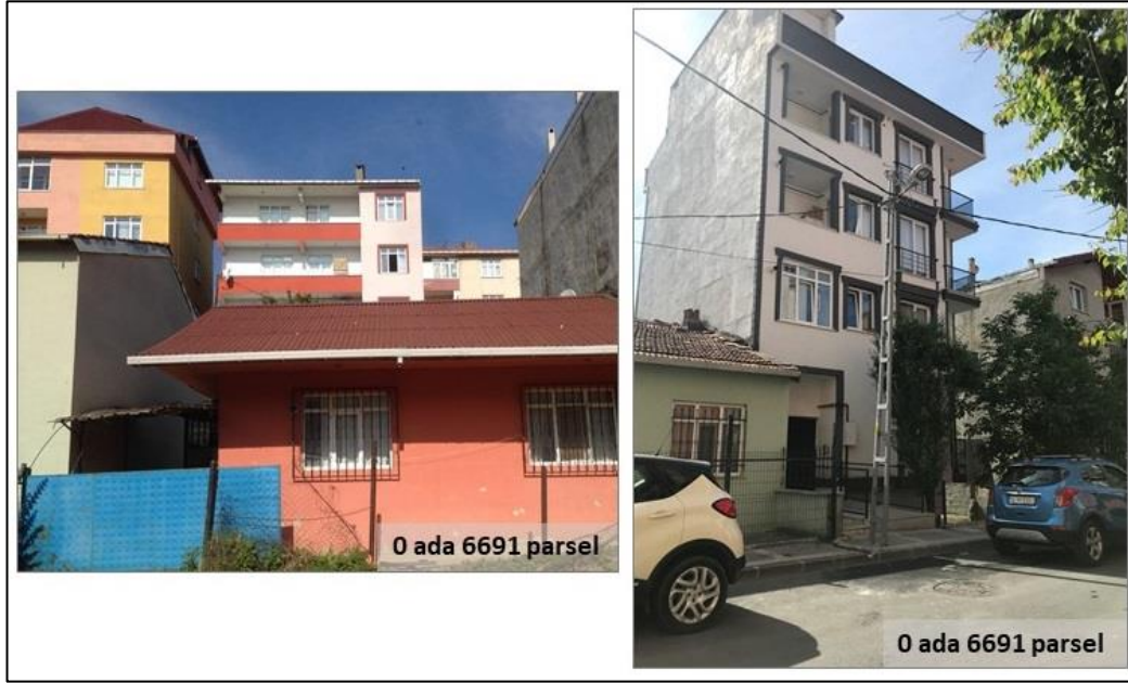
Şekil 4-28: 1 nolu örnek riskli yapı yıkım öncesi-inşa sonrası (Sol, ÇŞB-Kentsel Dönüşüm Bilgi Sistemi, Sağ Kişisel Arşiv, 2019)
