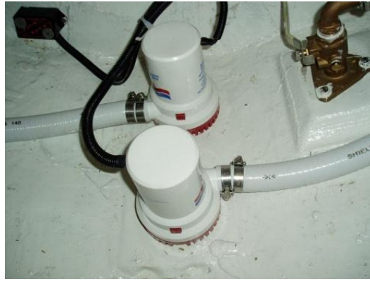
Şekil 2.135. Elektrikli sintine pompalarının montajı
