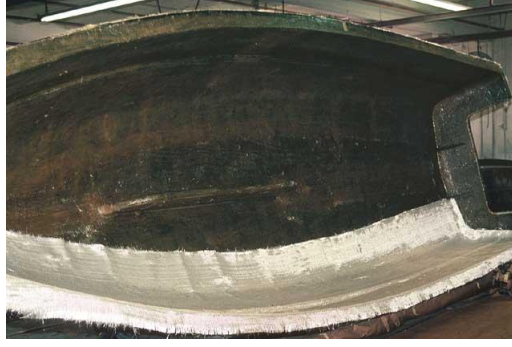
Şekil 1.44. Kalıba cam elyafı katlarının atılması
