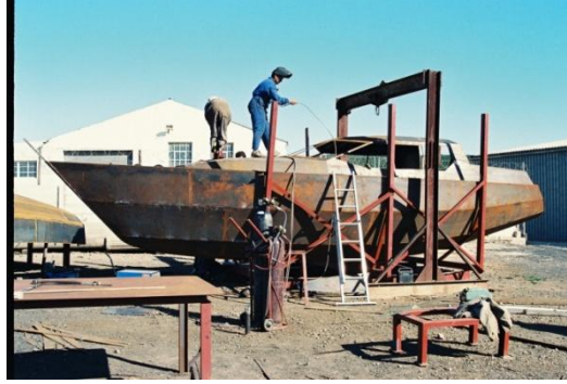
Şekil 1.40. Amatör sac tekne yapımına uygun çeneli gövde yapısı
