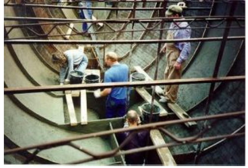
Şekil 1.47. İskeletin üzerine beton döküm işlemi
