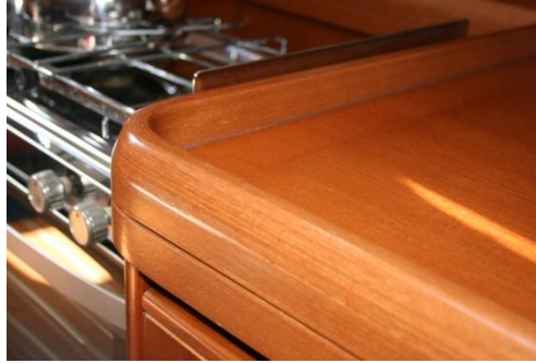
Şekil 2.60. Kuzine tezgahı kenarlarında bulunan set detayı
