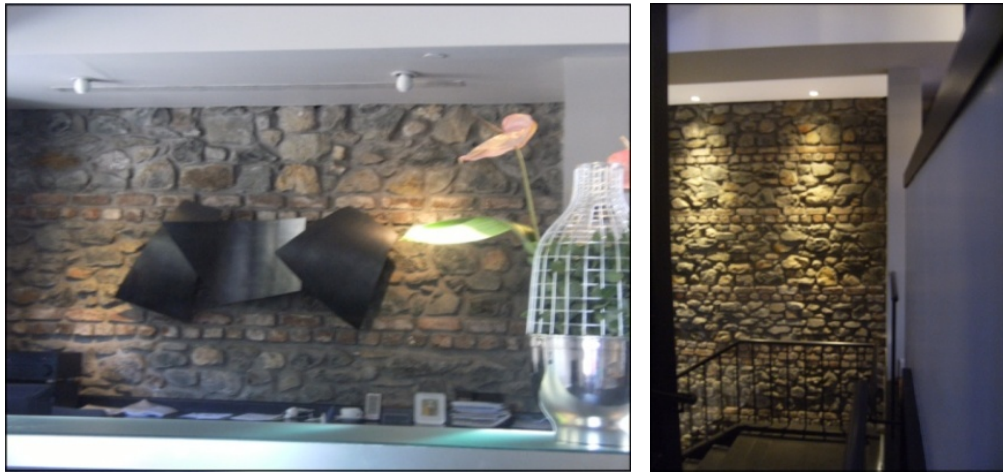
Şekil 5. 15. ve 5.16. Doğal taş duvar üzerinde yapay aydınlatma uygulamaları
