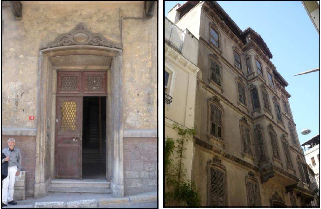
Şekil 5.37. ve 5.38. Zenovitch apartmanın görünüşleri
