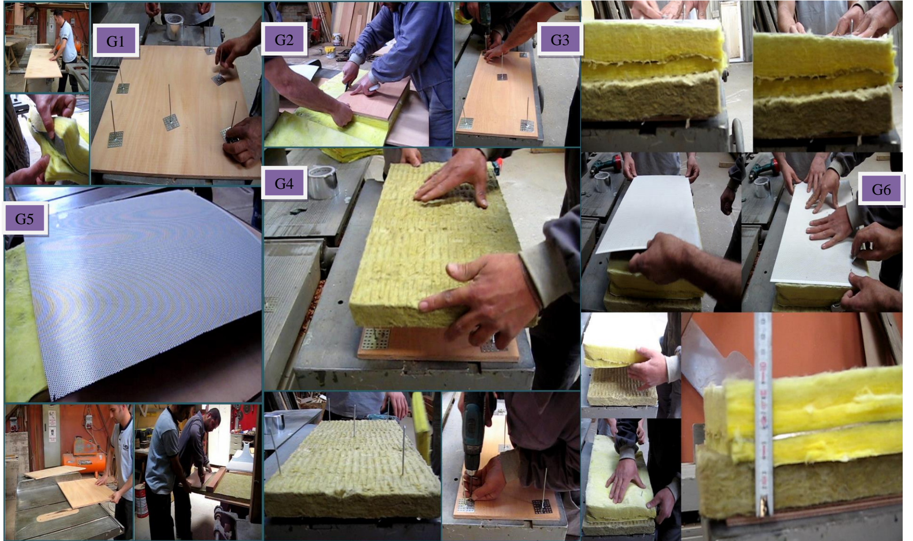
Resim 4-127 : -kişisel arşiv- Yatın fiziksel yanmazlık düzeyini arttırıcı, Tansu Yat Firmasına ait yalıtım çözümü G1: Kesilmiş su kontrastına izolasyon çivisinin çakılması G2: İzolasyon süngerlerinin kesimi G3,G4: kontraya montajı G5, G6 metal kaplama ile örtme
