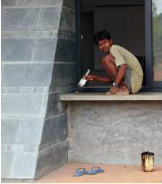
Şekil 4.5. Auroville Kentsel Araştırmalar Merkezi İnşaatı (URL-7, 2012)
