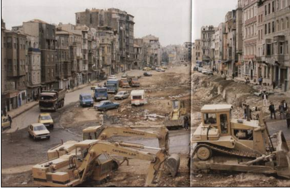
Fotoğraf 2: Tarlabası Bulvarı Yol Açma Çalışmaları - 1986
