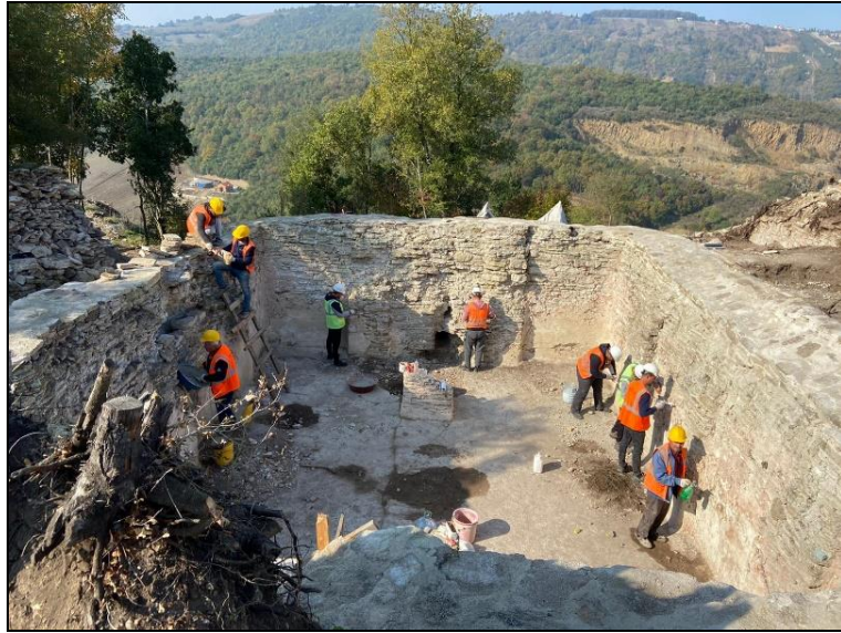
Fotoğraf 9: Sarniç koruma ve onarım çalışmaları
