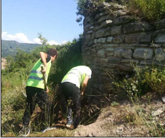
Fotoğraf 2-3: Surların Restorasyon Projesi Araştırma Sondajları
