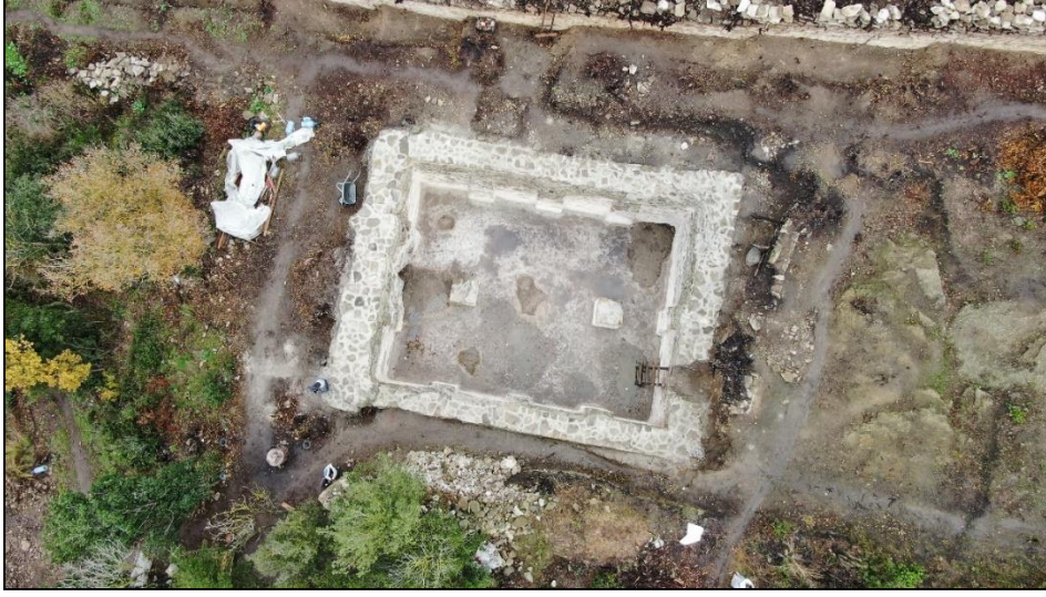
Fotoğraf 10: Sarnıç koruma ve onarım çalışmaları sonrası görünüm
