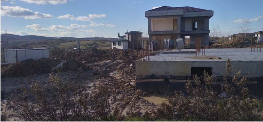
Şekil 3. 5: Gümüşdere Kısırkaya caddesi, 'Afet Konutları İnşaatı',2023
