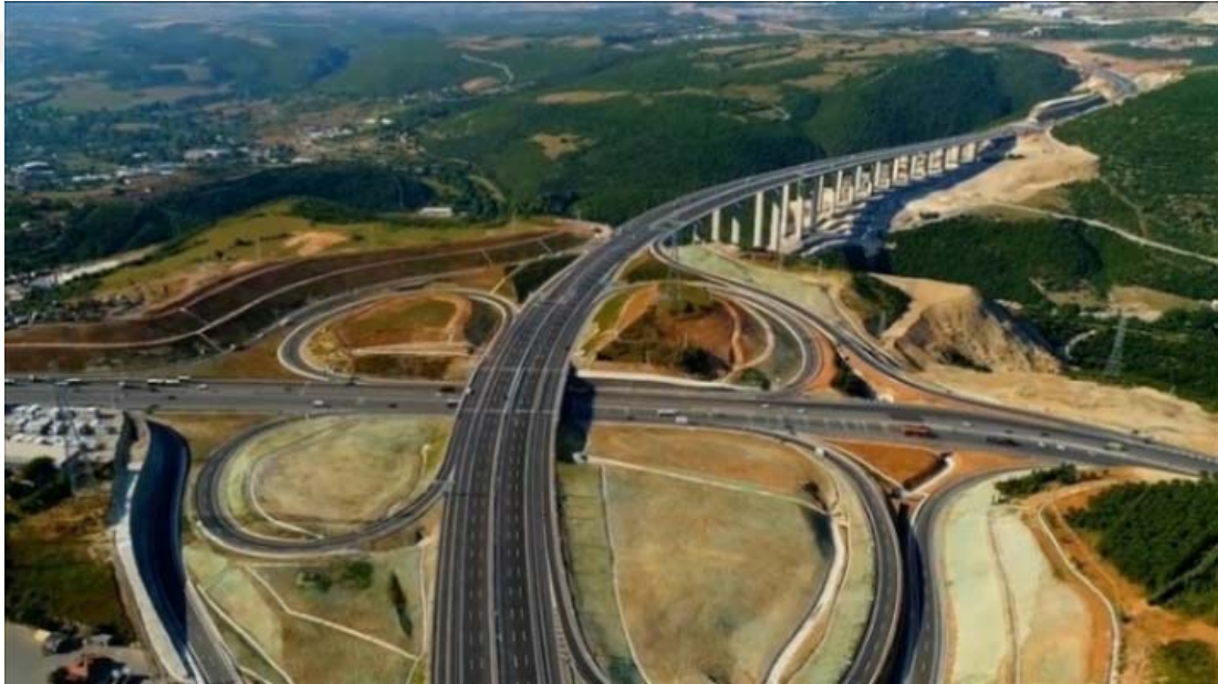
Şekil 5. 2: Yavuz Sultan Selim Köprüsü Kuzey Marmara Otoyolu
