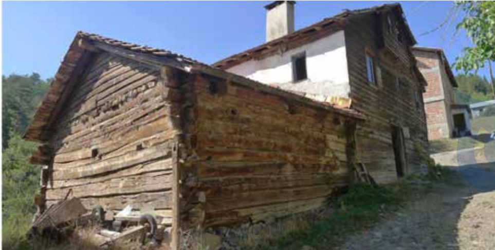
Fotoğraf 32: Mekânlar, dam ve bunlara ek olarak inşa edilmiş bitişik nizam tekil bir yapı sistematığına İmam Mahallesi'nden bir örnek (Burcu Büken Cantimur, 2014).
