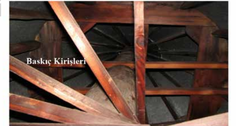
İmaj 53: Zıbıncı Camii minaresi yapısal sistemi
