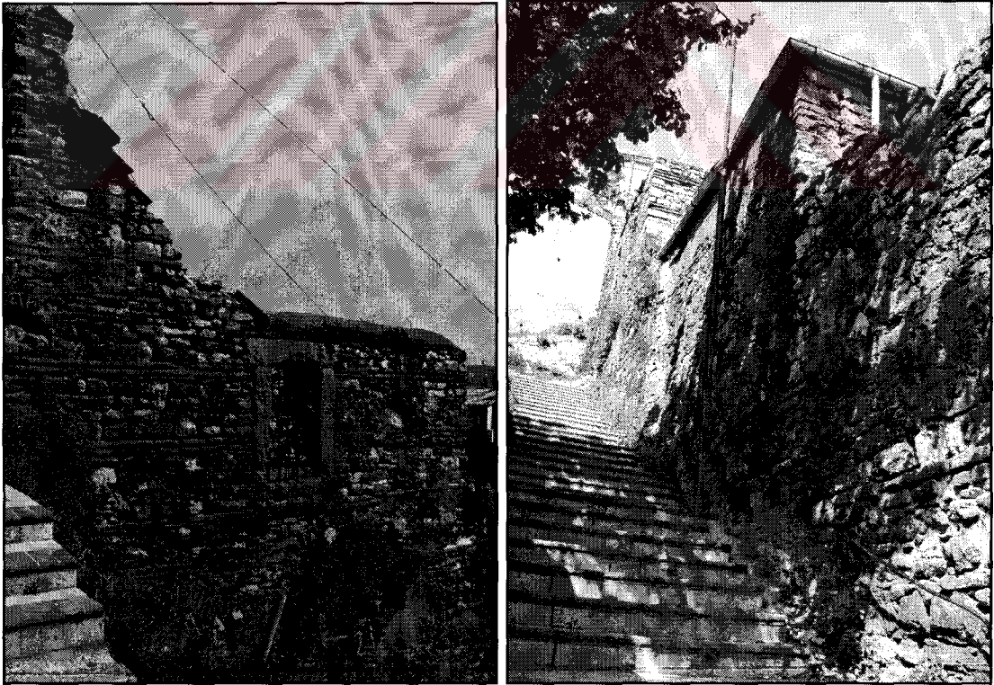
Resim 3-40.Merdivenli Mektep Sokak Görünümleri(Güney Cephesi)
