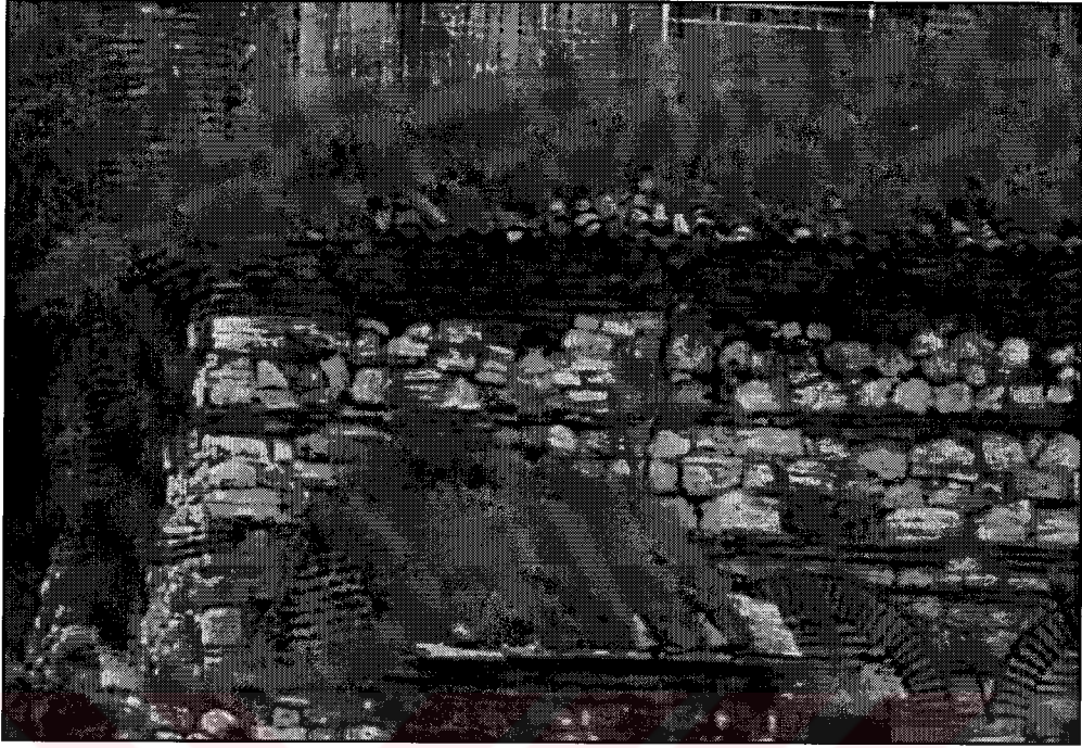
Resim 3-8.Kütüphanenin doğu cephesi kirpi saçak detayı.
