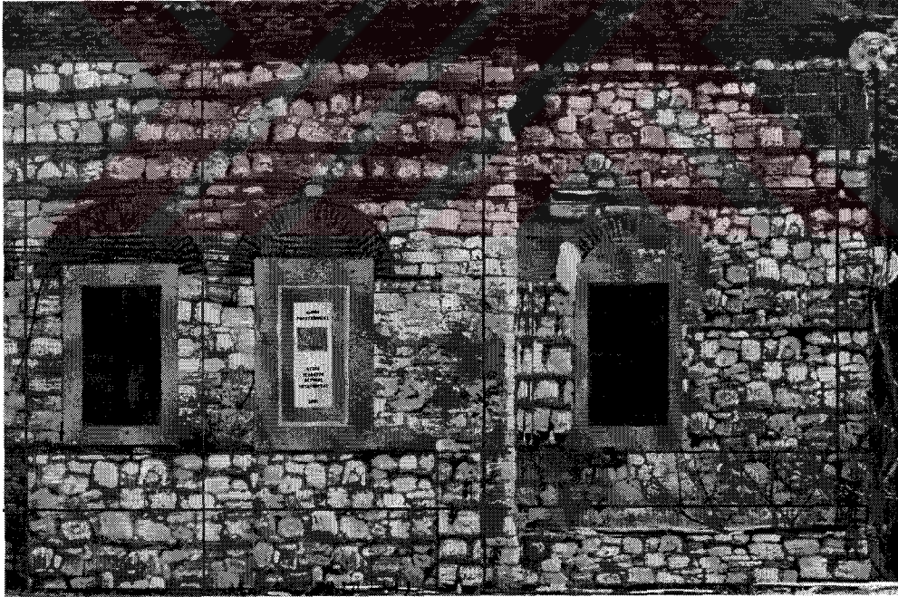
Resim 3-46.Karbon Elyaf Bantlarla Güçlendirilmesi önerilen Kütüphane Cephesi
