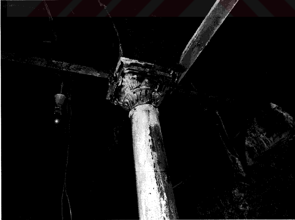
Şekil B- 12. 2304 Ada 12 Parsel İç Cephe Fotoğrafları
