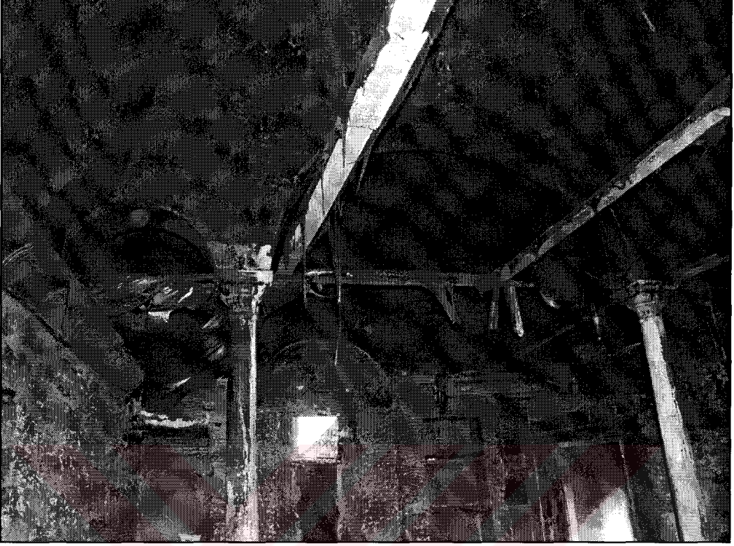
Resim 2-13.2304 Ada 12 Parsel 1. Kat Oda stunlar arası gergiler.
