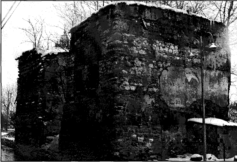
Resim 2-3. 2304 Ada 12 Parsel Mürselpaşa Cephesi.
