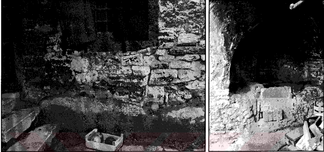
Resim 3-44. Doğu Cephesi Taş Yüzeylerde Kirlenme
