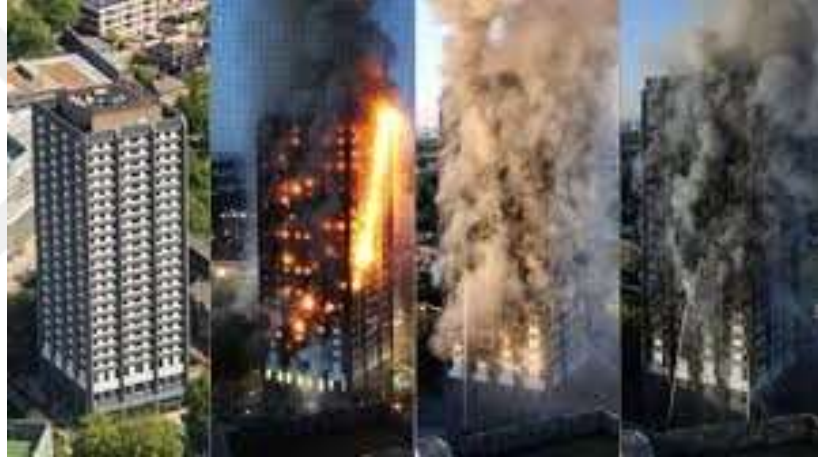
Şekil 4.3 : Grenfell Tower Yangını Gelişimi (Kılıç, 2017a).
