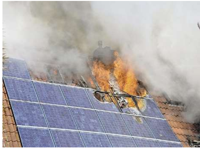
Şekil 4.6 : PV Panellerin Çatıda Yarattığı Yangın Riski (Shipp, 2010).
