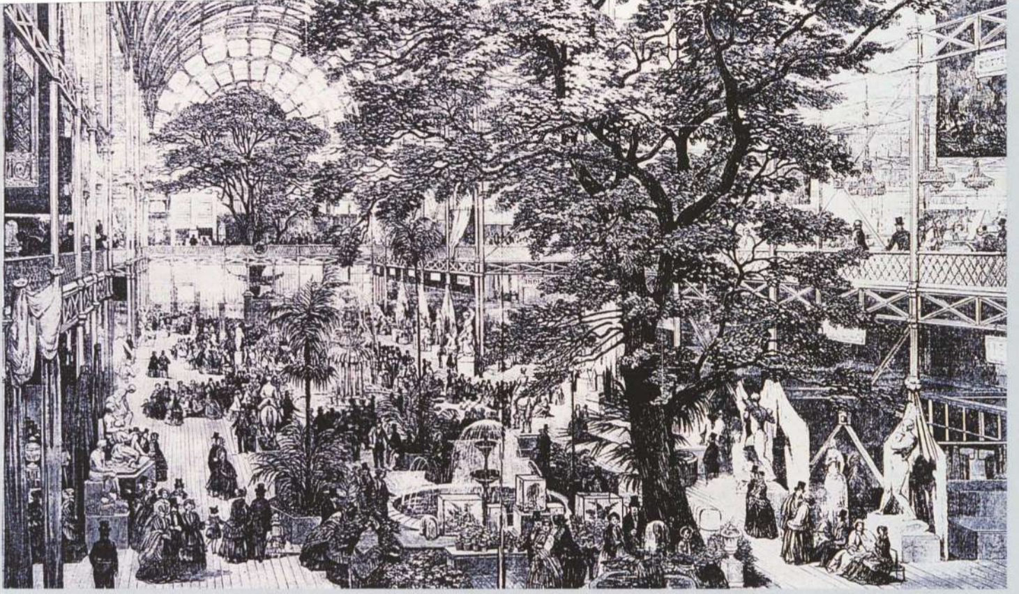
"Crystal Palace" binasının büyük iç meydanlarından bir görünüş. (Önder Küçükerman arşivi)
