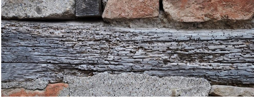
Şekil 2.3: Böceklerin ahşaba açmış olduğu uçma delikleri ( Kaynak: Betülner Hülagü )
