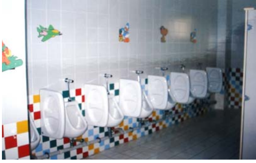
Resim 4.22. Bahçeşehir Koleji WC İç Görünüşü
