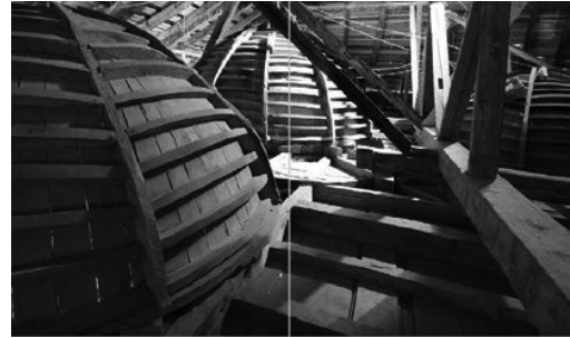
Fig. 7. Ghorcomi Camii'nde bağdadi tekniğinde yapılan gizli kubbelerin çatı arasından görünümü (Brandts et al. 2018)
