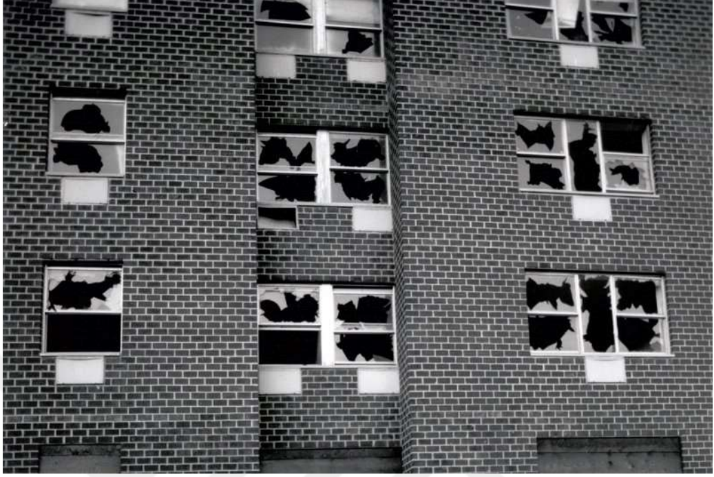
Şekil 43: Window Blow-Out, 1976 (CCA Arşivi).
