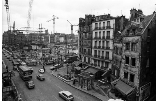
Şekil 42: Centre Pompidou inşaatı ve Les Halles (Mark Petitjean).
