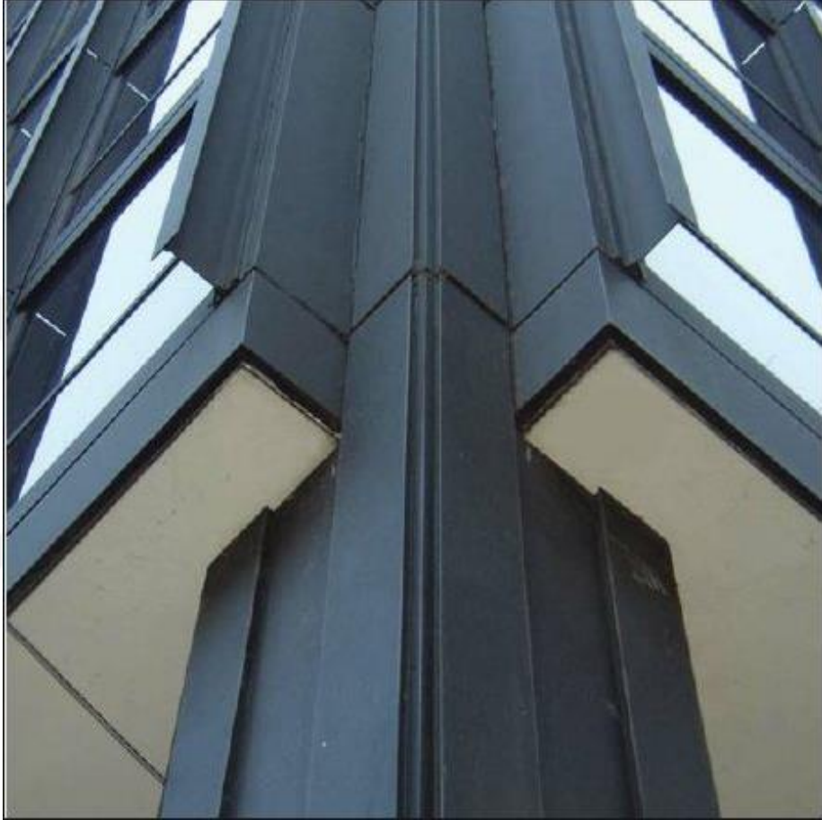
Şekil 3.5: Köşe Detayı, Lakeshore Drive Apartments, Chicago, Mies van der Rohe, 1948.
