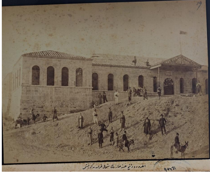
Resim 20: Hastanenin inşaatı devam ederken, kuzey yönden çekilmiş bir fotoğrafı. Fotoğrafın altında, “Ankara'da vâki Hastahanenin şimâl tarafından görünüşü”. (İ.Ü., Nadir Eserler Kütüphanesi, II.Abdülhamid Albümleri, No: 90431.0039)
