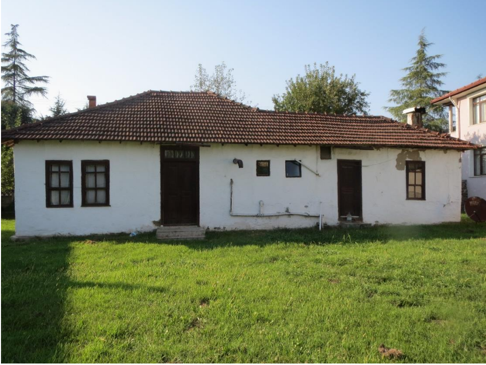
EK-3 Fotoğraf – Anonim / Köprübaşı Köyü - Düzce
