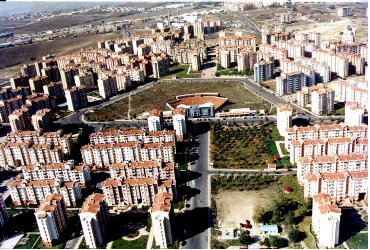
Resim 3: Esenkent'te inşa edilen ilk konutlar ve Rifat Ilgaz Açık Hava Tiyatrosu
