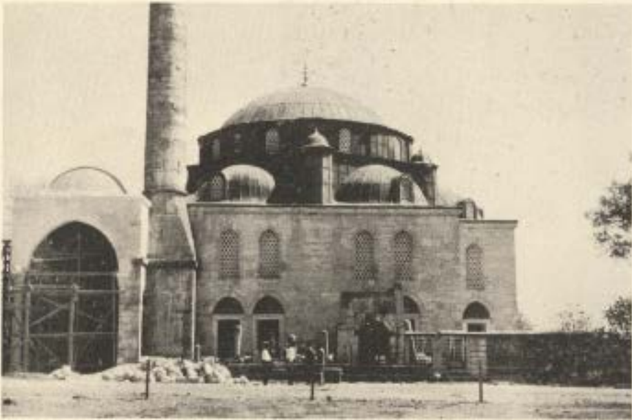
Resim: 31 b - Fındıklı Molla Çelebi Camii'nin son cemaat revakı inşa edilirken, batı cephesi (1958)
