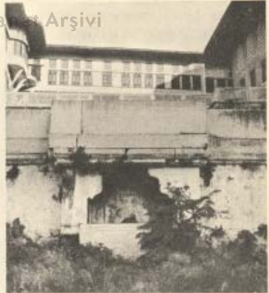
Resim: 8 - İkbâl Dairesi taşlığının önündeki havuzun sed duvarında bulunan bu çeşmenin üst kısmı kesik olan kemeri dilimli biçindedir
