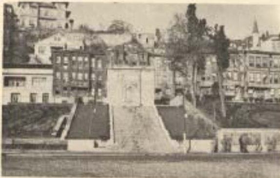
Resim: 32a - Aynı çeşmenin etrafı açıldıktan sonra ortada görünüşü (1939)
