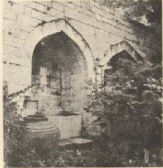
Resim: 4 - Hasahır karşısındaki sed duvarında bulunan çifte çeşme. Kemerleri basık sivri biçimindeki klasik tarz kemerlerdendir
