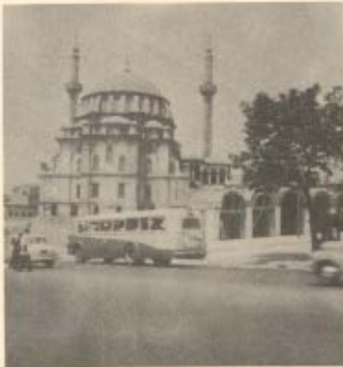
Resim: 16* - Lâleli Camiinin altında dükkân inşaatı için sed duvarı yıkılırken, yıl 1957
