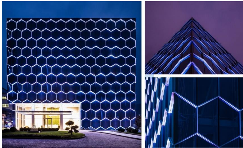
Şekil 4.31 : Biovet Yönetim Binası ve altıgen cephe geometrisinin görüntüsü (Novoselski, 2016).
