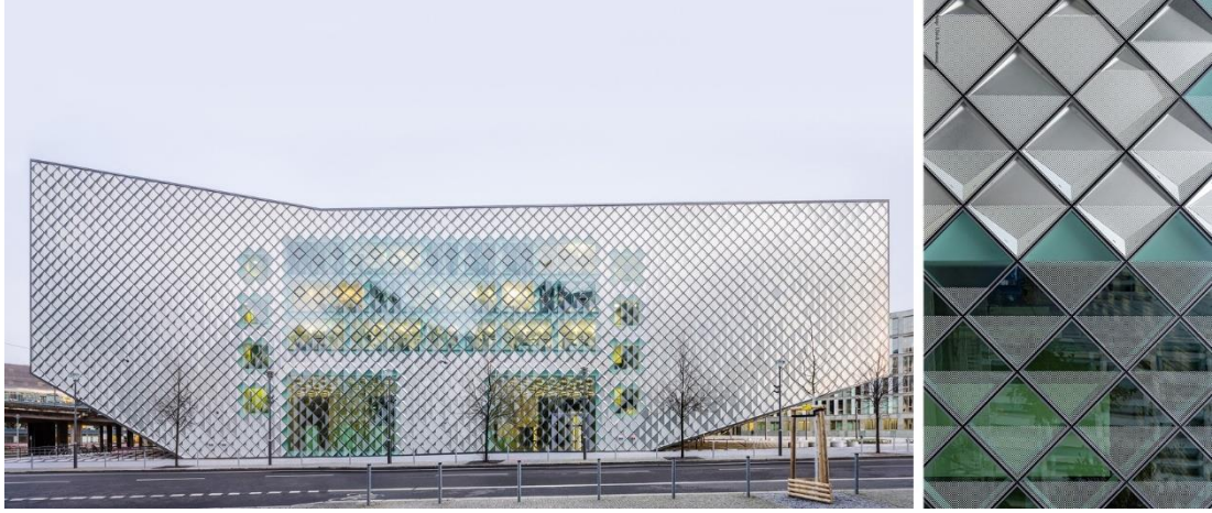
Şekil 4.23 : Futurium Berlin binası ve eşkenar dörtgen cephe geometrisinin görüntüsü (Groza & Renou, 2018).
