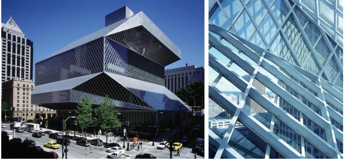
Şekil 4.29 : Seattle Halk Kütüphanesi Binası ve cephe geometrisinin görünümü (Ruault, 2004).
