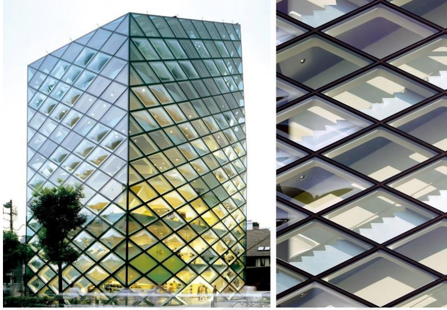
Şekil 4.27 : Prada Aoyama Binası ve eşkenar dörtgen cephe görüntüsü (Marburg ve diğerleri, 2017).
