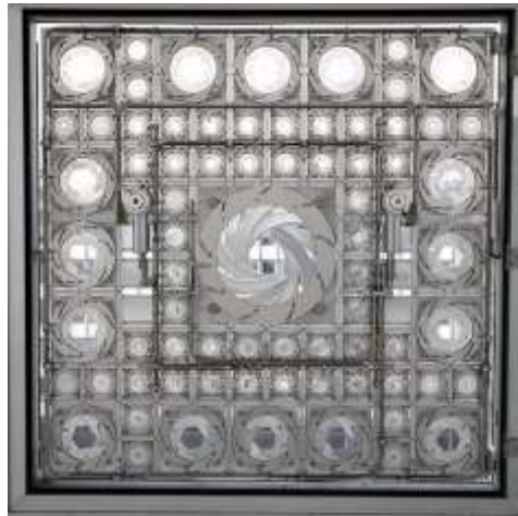
Şekil 2. 14 : Institute du Monde Arabe kinetic cephe modülünün farklı açıklıkları.
