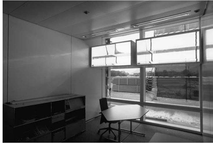
Şekil 3.12: LESO Binası DIANE Aydınlatma Laboratuvarı Anidolik Zenital Açıklık Sistemi(Url-16)
