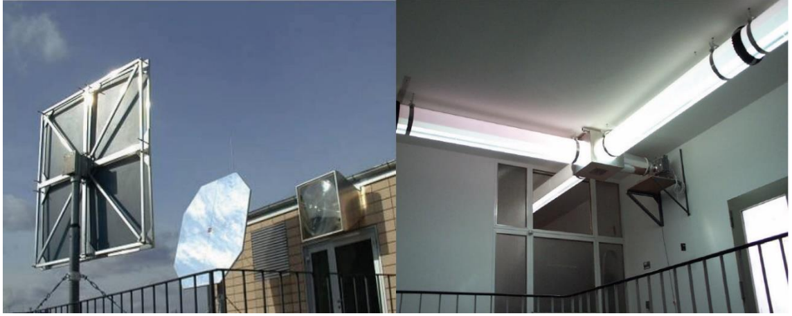
Şekil 3.37: Berlin Teknik Üniversitesi Işık Kılavuz Sistem Örneği(Özgün, 2007)
