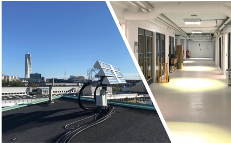
Şekil 3.49: Parans Fiber Optik Gün Işığı Sistemi–Malmö Müzesi(Url-22)
