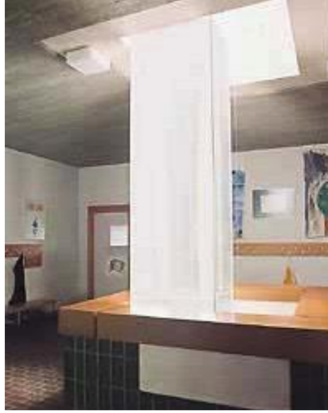
Şekil 3.35: Heliobus St.Gallen Örneği (Kare Kesitli Gün Işığı tüpü Gün Işığı Şaftı ve İçerisinde Bulunan Kare Kesitli Gün Işığı Tüpü)(De Vecchi et al., 2004)
