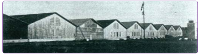
Şekil 2. Yeşilköy Hava Meydanı Hangarları, İstanbul. 6
